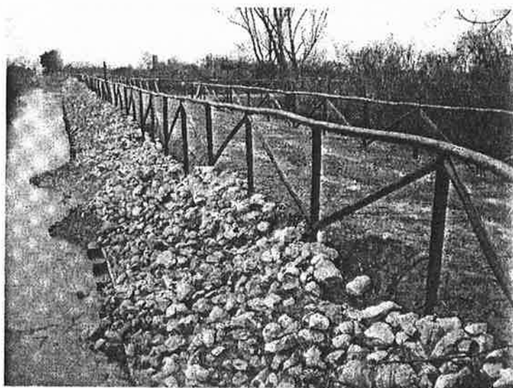
Fig. 2 – difesa spondale lungo la via di accesso al casone. Sono visibili franamenti di modesta entità.
