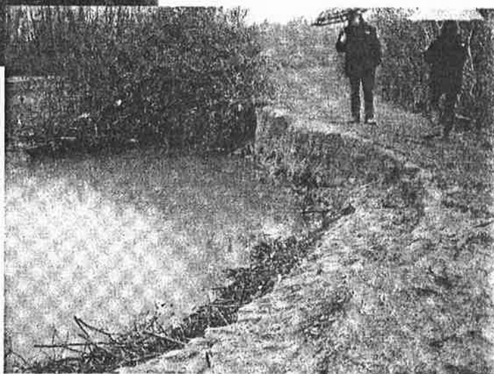
Fig. 4 – erosione di sponda ad opera del Po di Maistra
